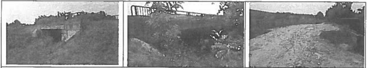
Pod pe grinzi din beton armat - km - 3+533
