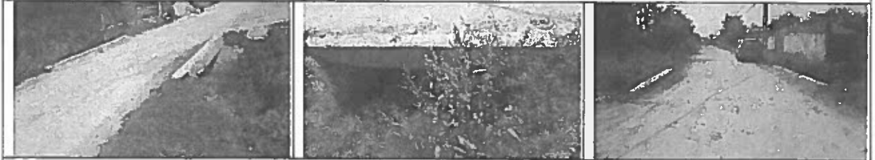
Podet dalat din beton armat - km - 5+272
