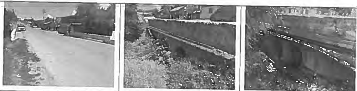
DJ 246, km 4+740 (Afluent Râu Dobrovăț, Com. Codăești)
