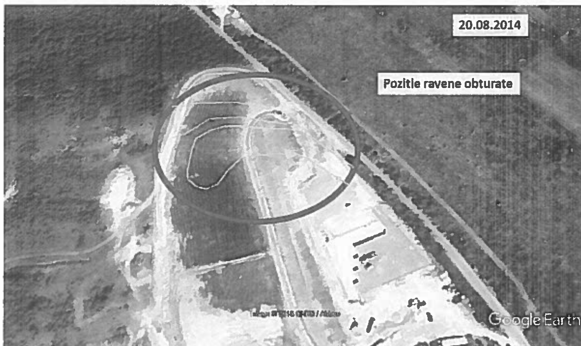
Fig. 7. Ravenele au fost obturate total, prin inceperea lucrarilor de inchidere a depozitului de deseuri.
