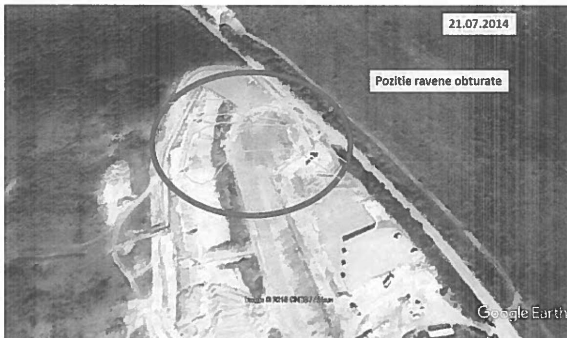
Fig. 6. Ravenele au fost obturate total, prin inceperea lucrarilor de inchidere a depozitului de deseuri neconform.
