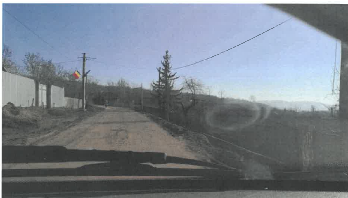
Fig. 03 Îmbrăcăminte asfaltică existentă
